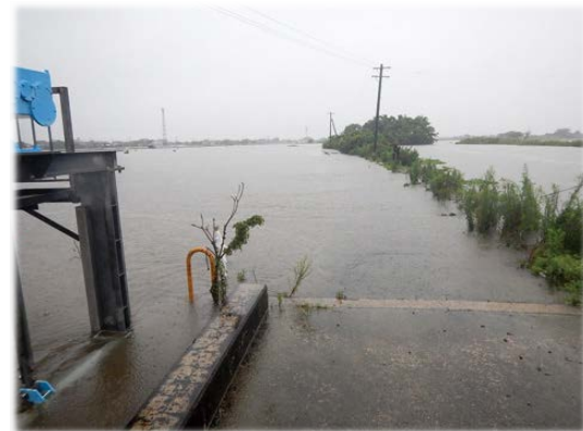
花宗川溢水状況（下田町地区）
