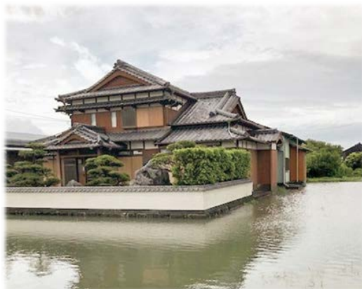
7月6日の豪雨により冠水した家屋周辺
