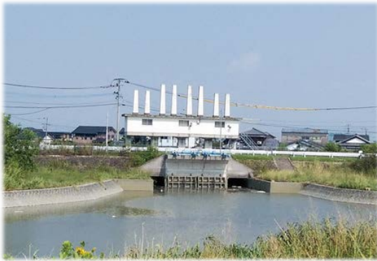
若宮排水樋門
