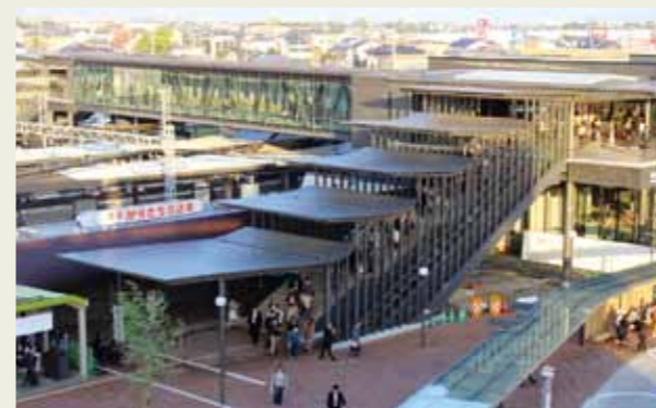
柳川駅周辺整備事業で整備した自由通路と駅前広場
