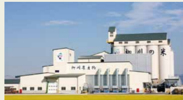
強い農業づくり交付金事業で整備された、JA 柳川東部地区カントリーエレベーター（久末）
