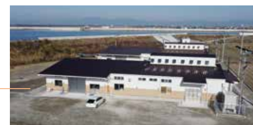
沖端地区ノリ共同加工施設
