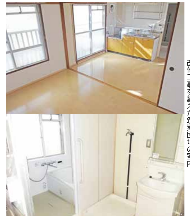
改修工事を終えた筑紫団地の室内
