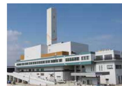
新ごみ焼却施設「有明ひまわりセンター」。11月から試運転を開始
