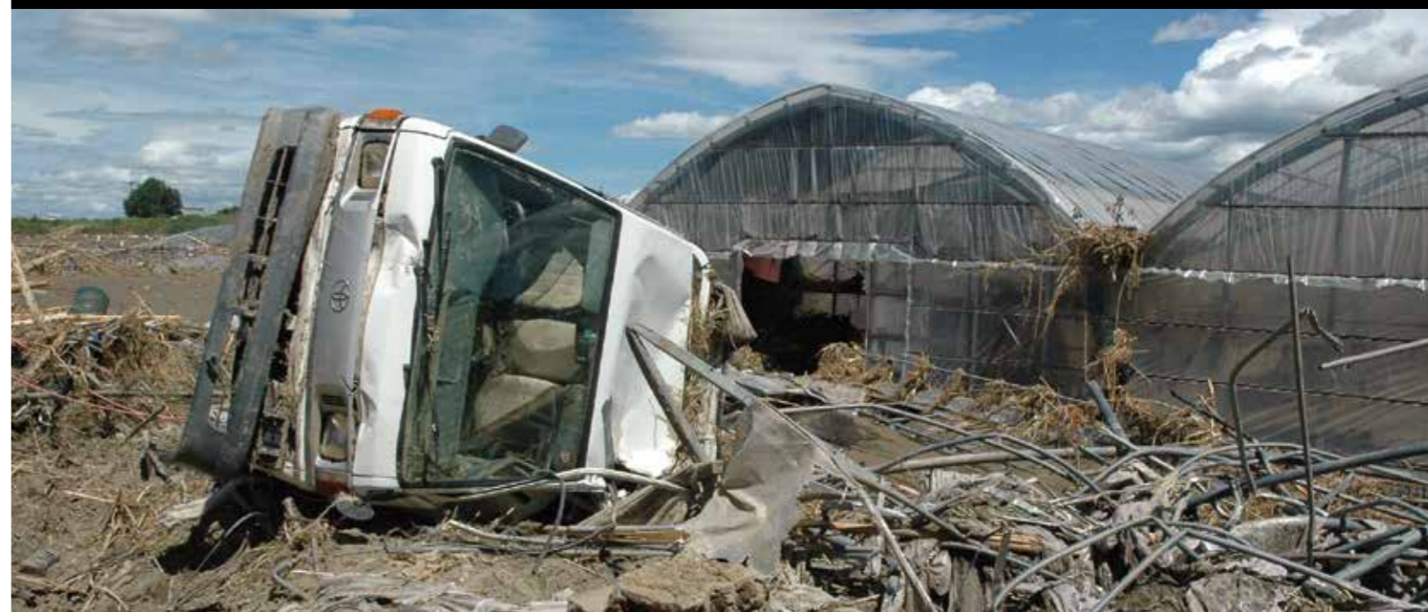
押し寄せてきた濁流と流木で倒壊した中山地区のビニールハウス（平成24年九州北部豪雨）
