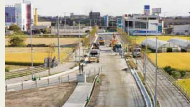
有明海沿岸道路「柳川西インター」と枝光を結ぶ大和枝光線。今年度開通予定
