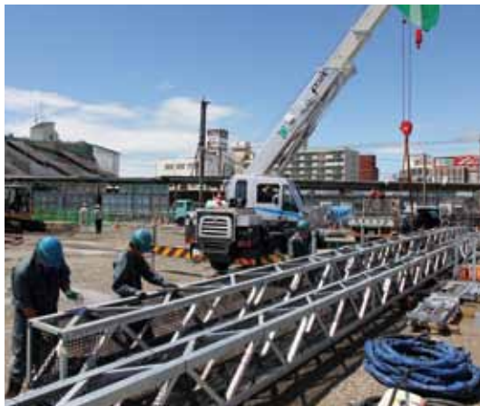
駅では、自由通路建設のための工事が8月から開始。駅が完成するまでの約2年間、駅利用者にはご迷惑をおかけしますが、ご理解とご協力を
