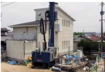
排水能力が2倍になる筑紫町ポンプ場
