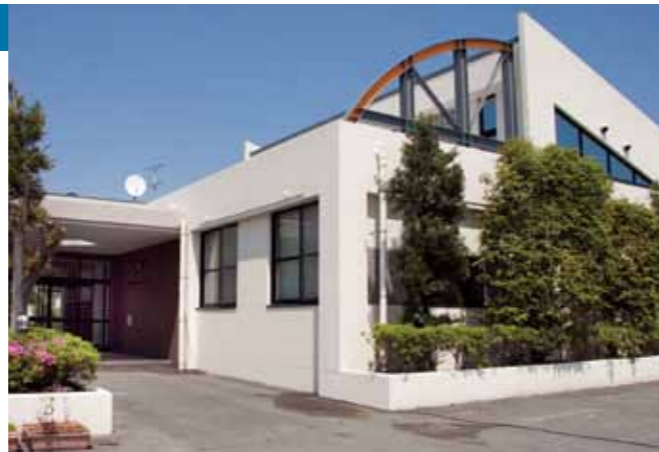
改修工事が終了した両開公民館
