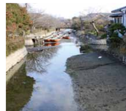
【上】6枚の板でせき止められた新町水門【左】掘割の水を抜くため、二丁井樋を開けた【下】2、3日で水位が下がり、川底が顔を出した
