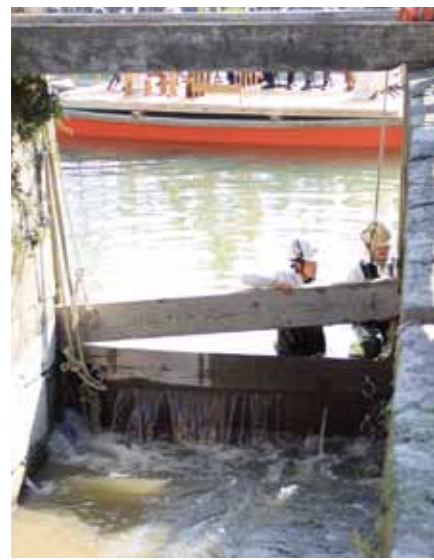
【上】川下りの安全を祈願した後、新町水門の板を1枚ずつ取り外した【下】水門の板を外すと、きれいになった掘割に水が音を立てながら勢いよく流れ込んだ
