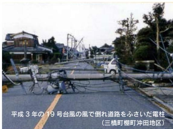
平成3年の19号台風の風で倒れ道路をふさいだ電柱（三橋町棚町沖田地区）
