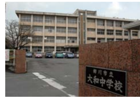
改築に着手する大和中学校校舎
