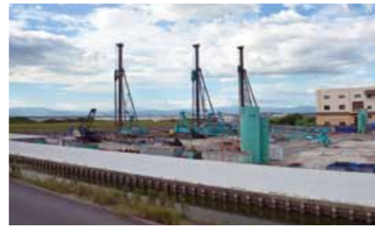
建設中の新ごみ焼却施設
