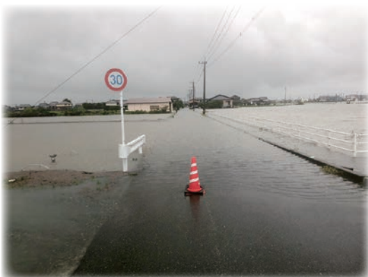
大雨による道路の冠水
