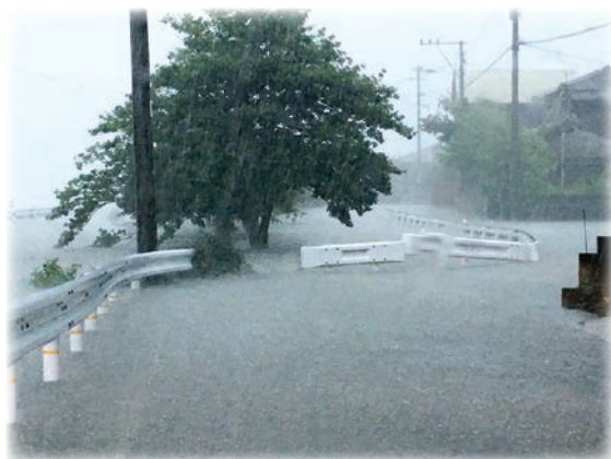
大雨による道路冠水
