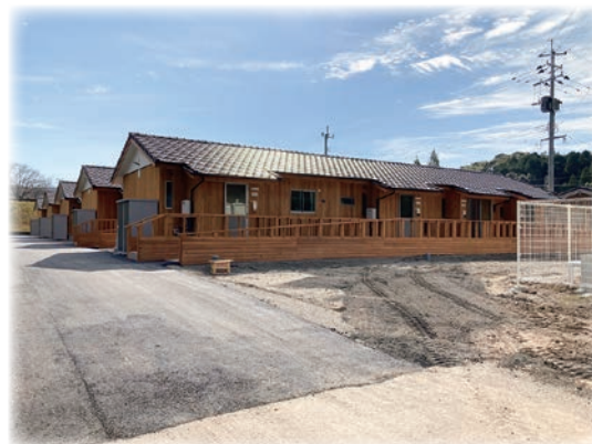
人吉市の木造づくりの応急仮設住宅
