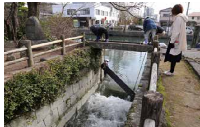
水をせき止めていた6枚の板を1枚ずつ取り外す関係者
