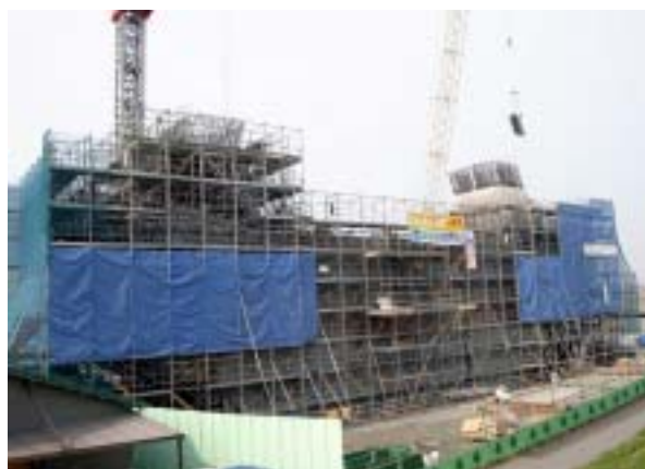
平成20年春の供用開始を目標に急ピッチで工事が進む有明海沿岸道路
