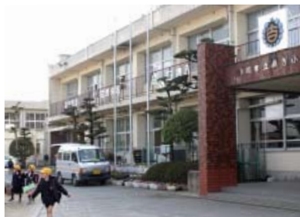
大規模改修が予定されている藤吉小学校
