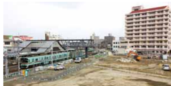
▲整備が進む西鉄柳川駅東側。来年3月には自由通路や駅前広場が完成する予定
