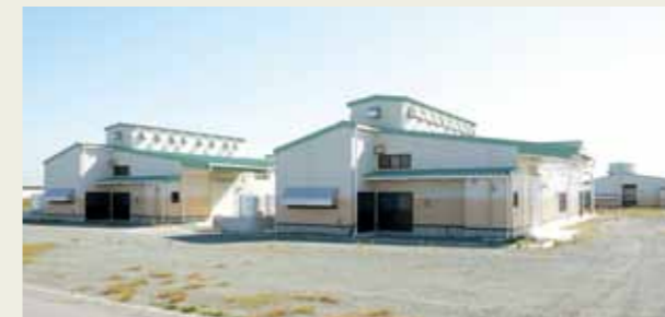
中島漁港漁業団地に両開漁協分 2 棟と大和漁協分 1 棟（写真右奥）のノリ共同加工施設が国と県の補助を受けて完成
