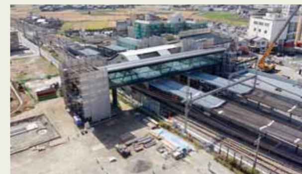
西鉄柳川駅ホームの上に建設中の自由通路。東口と西口の駅前広場も来年 3 月完成に向けて工事が進行中
