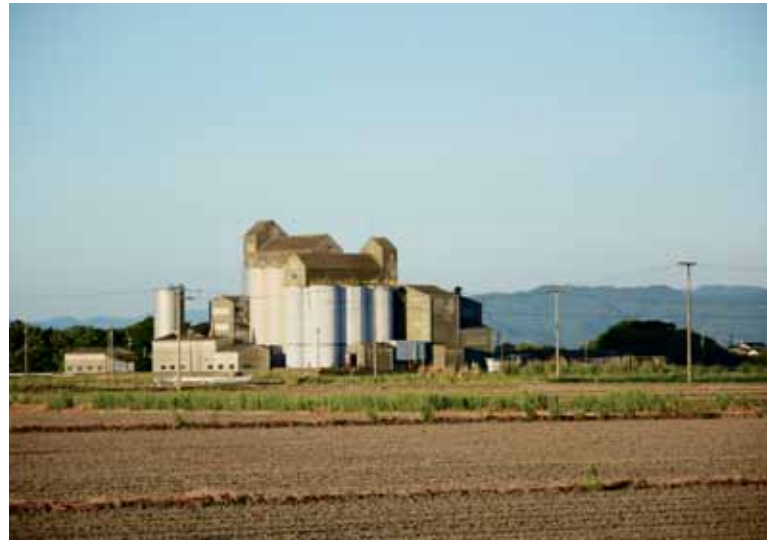
カントリーエレベーター
