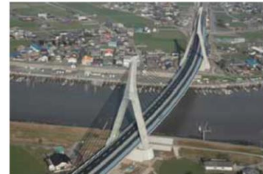
図 2-19 有明海沿岸道路
