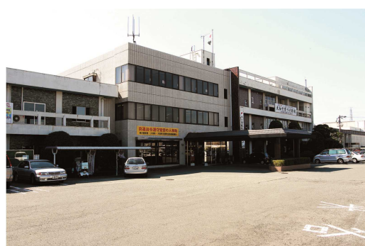
やまとちょうしゃ 大和庁舎 大和厅舍
