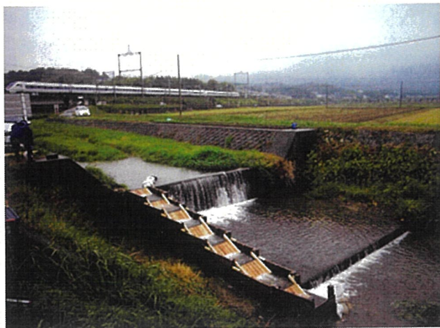
斜め坂を取り付けた魚道
