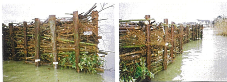
完成した消波堤
