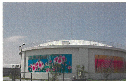
配水池（矢加部配水場内）
