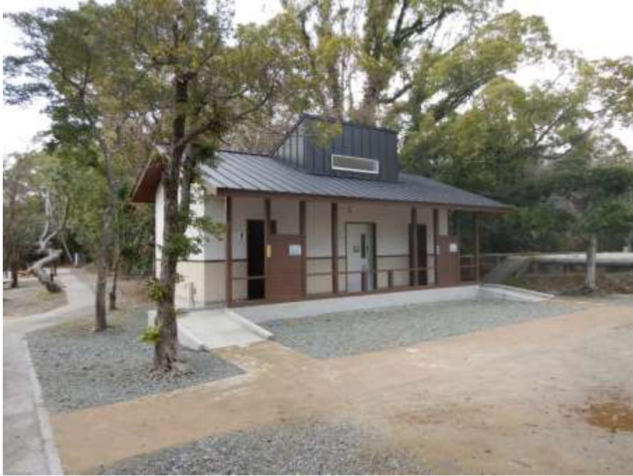
写真① (施工後)
