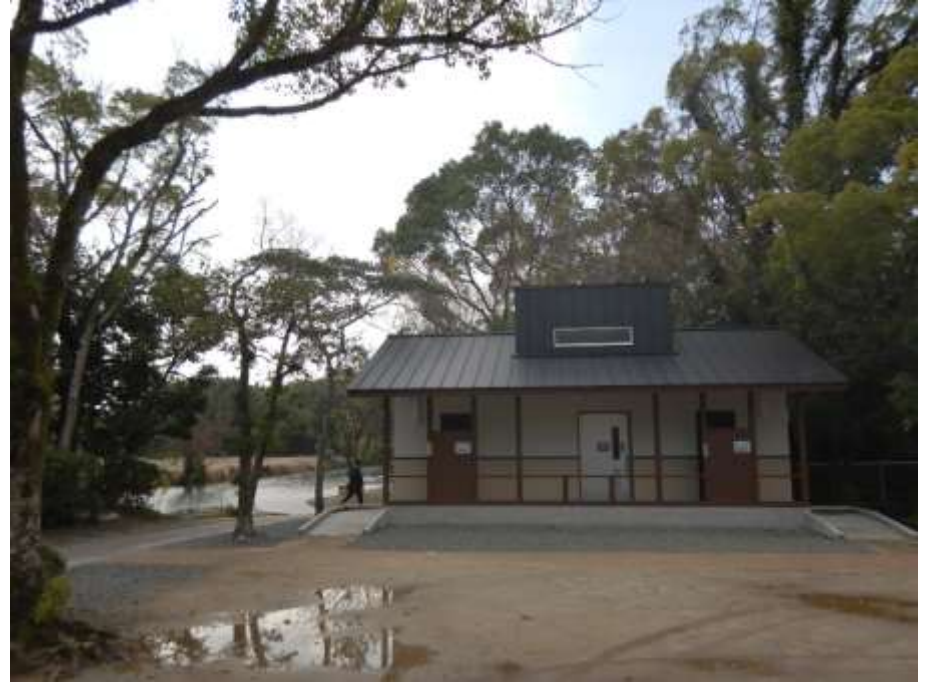
写真② (施工後)
