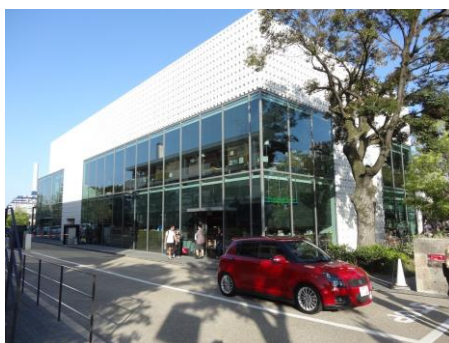
ガラスウォールを用いて開放的な店舗空間をつくっています（他都市の例）
