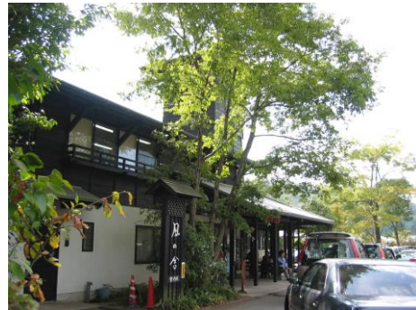
建物周辺を緑化することで、建物の規模に対する印象を抑え、周囲の景観と調和しています（他都市の例）
