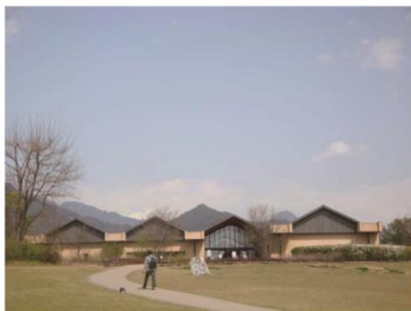
建物を分節することで、周囲の景観と調和しています（他都市の例）
