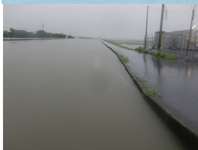
大雨時の幹線水路
