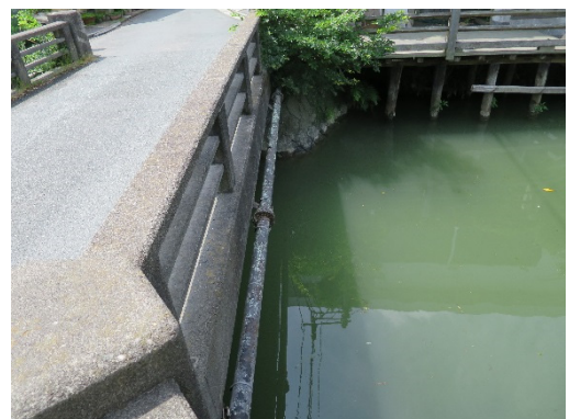
図 6-3 橋桁に隠れる配置となっている水道管
