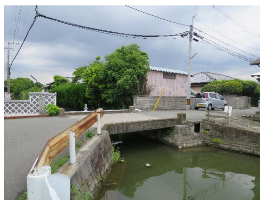
図6-5 掘割を横切る電柱の架線
