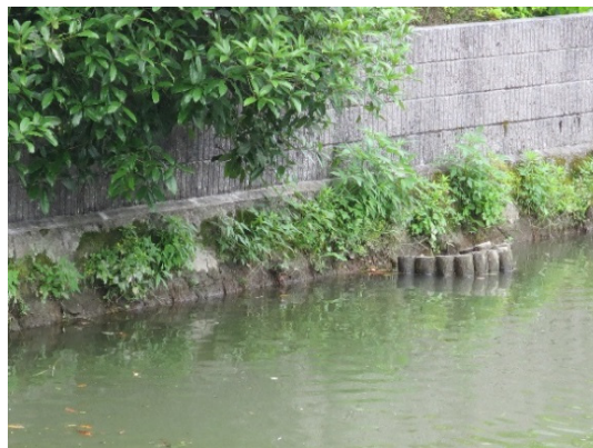
図6-4 詰杭による修景が行われている排水管
