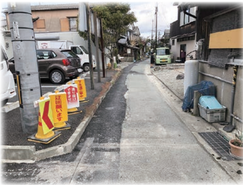
下水道工事中の道路
