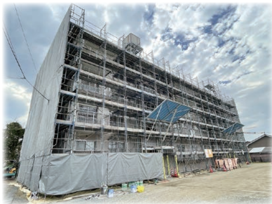
改修中の市営筑紫団地
