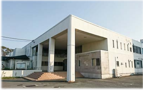
柳川市民温水プール
