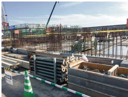
建設中のごみ焼却施設
