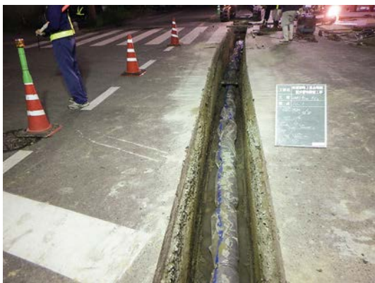
水道管布設工事の様子
