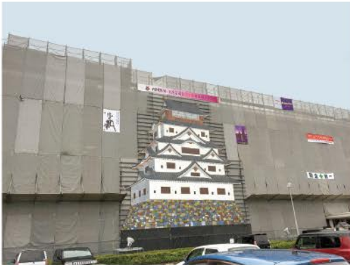
柳川庁舎外壁工事
