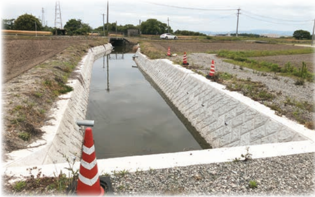
三橋町磯島地区護岸工事
