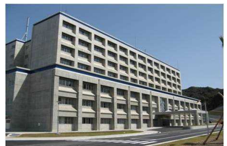
隊庁舎(高知駐屯地)
