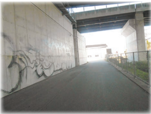
有明海沿岸道路矢加部高架下の状況
