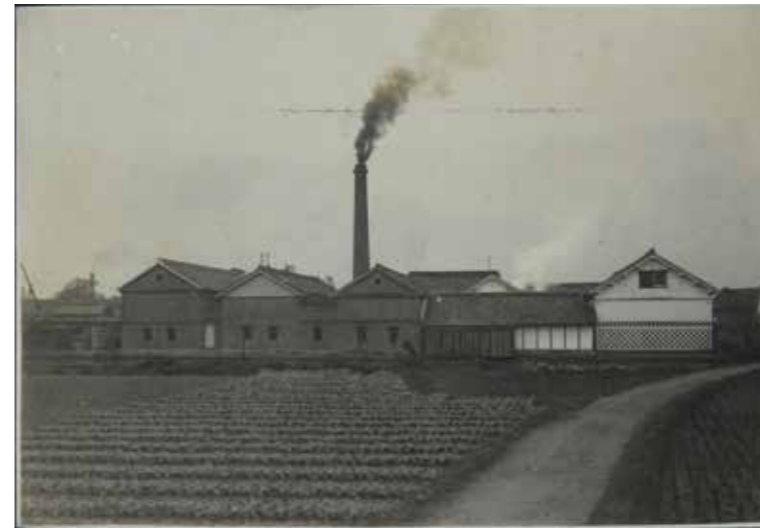
【写真2】左から並倉の北棟、中棟、南棟、洗い場（吉開家蔵）
