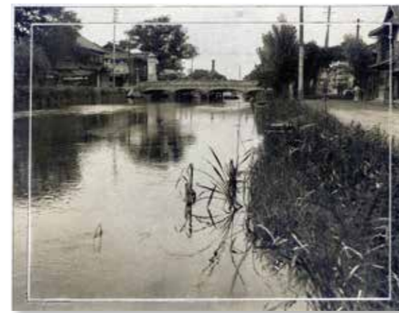
【写真2】南から見た3代目柳川橋
