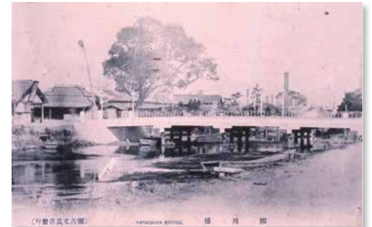
【写真1】南から見た2代目柳川橋
