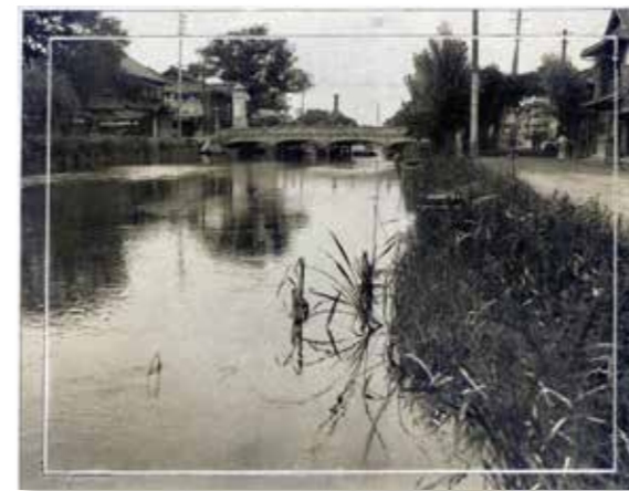
【写真2】南から見た3代目柳川橋
