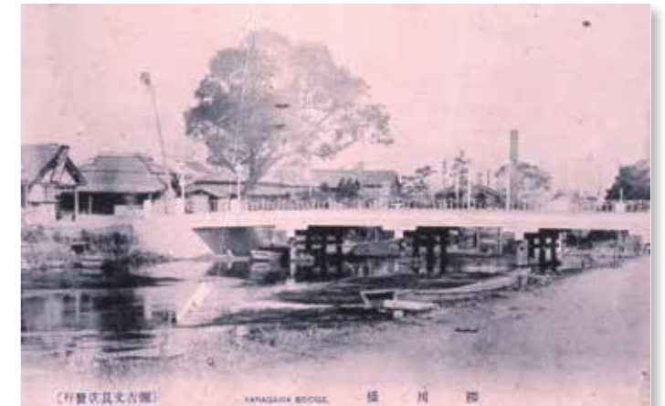
【写真1】南から見た2代目柳川橋
