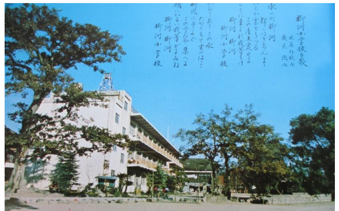
昭和39年 鉄筋校舎完成
