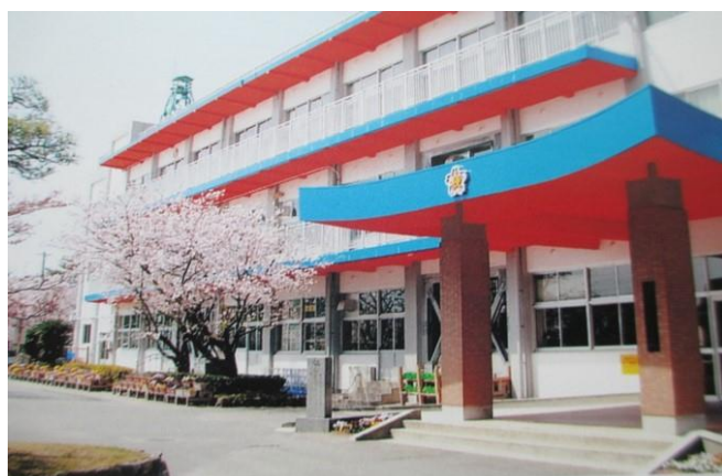
平成21年 北校舎耐震工事
