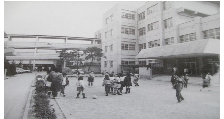
昭和59年 南校舎昇降口の様子
