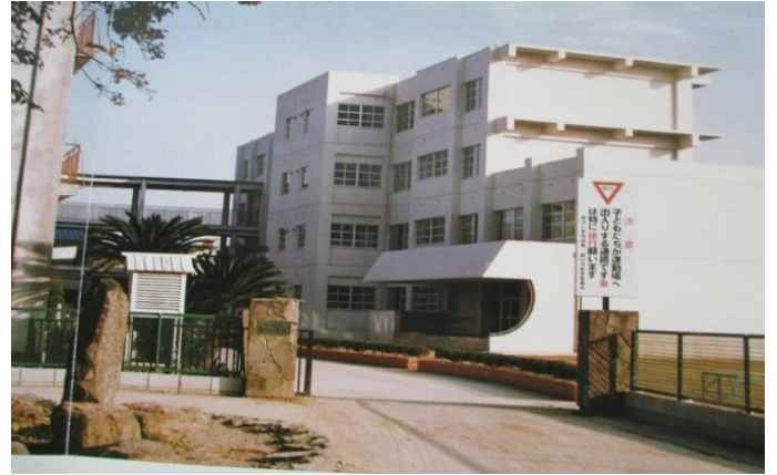
昭和57年 南4階校舎完成
