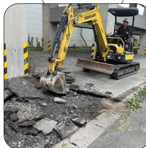
①舗装版破碎
