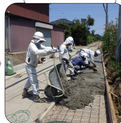
②基礎コンクリート打設
