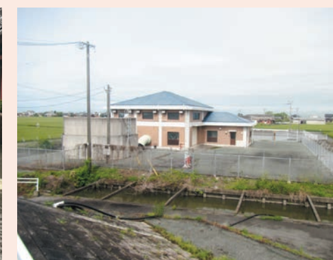
修繕予定の排水機場
