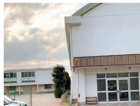
中学校体育館と武道場
