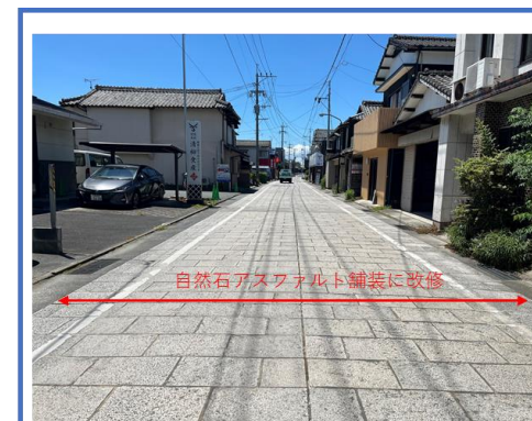
①県道大牟田川副線舗装工事 (発注者：福岡県南筑後県土整備事務所 柳川支所 道路維持課)
