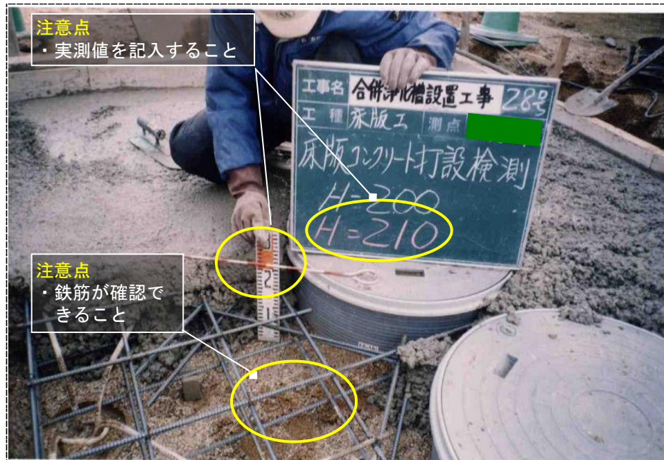
写真（９－２）【スラブコンクリート工】全景写真
