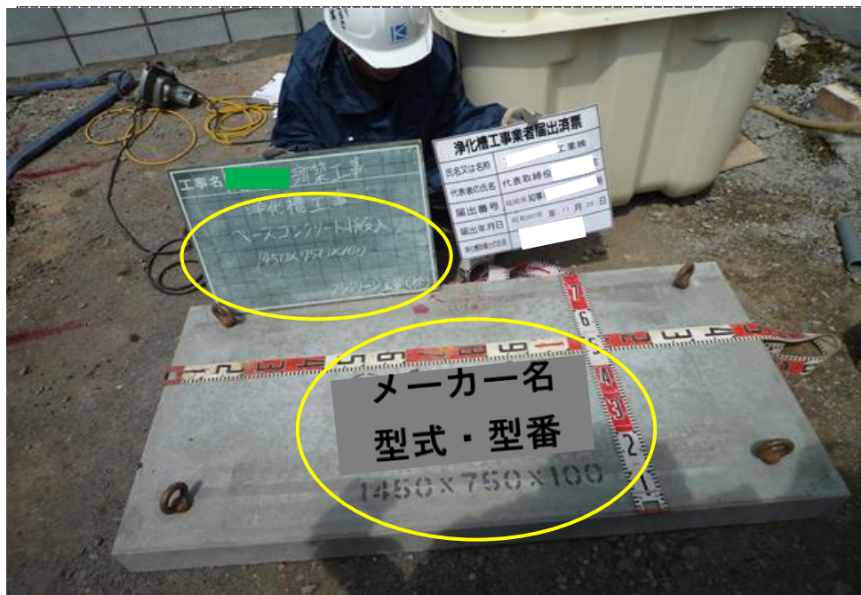
写真（１８－２）【ＰＣ版設置工】ＰＣ板設置時の写真
