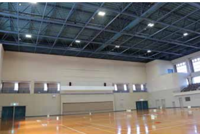
改修工事を行うメインアリーナ
