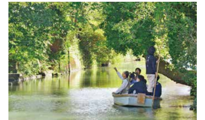
どんこ舟に乗って掘割沿いの樹木の状態を確認する関係者
