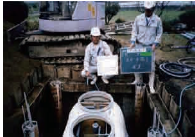
合併処理浄化槽の設置
