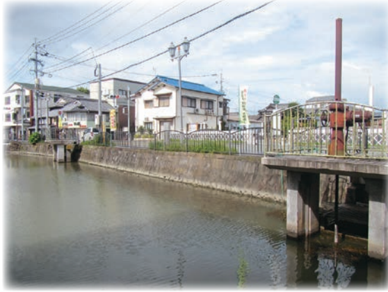
排水ポンプ設置予定場所
