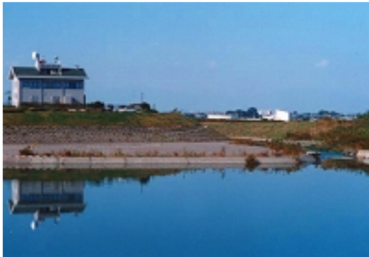
<矢部川から沖端川へ水を取り入れる松原せき>
