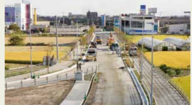
有明海沿岸道路「柳川西インター」と枝光を結ぶ大和枝光線。今年度開通予定
