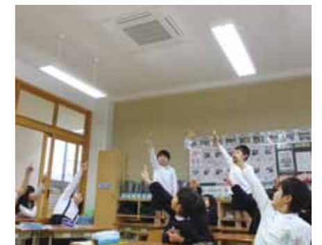
市内小中学校には学習環境の向上のため冷暖房設備を設置（写真：ニッ河小学校）
