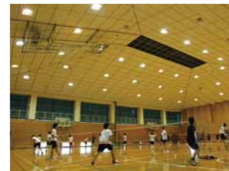
吊り天井式の小中学校体育館は落下防止のための工事を行う（写真：大和中学校）
