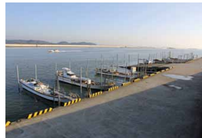
中島漁港の漁業団地では利用者の増加のため、物揚場を約50m延長し対応する（工事は28年度の予定）
