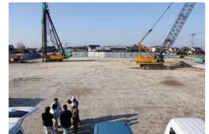
東宮永団地（仮称）の建設地（佃町）。本町と鳥の水団地の老朽化に伴い建て替えを行うもので、60戸を整備予定
