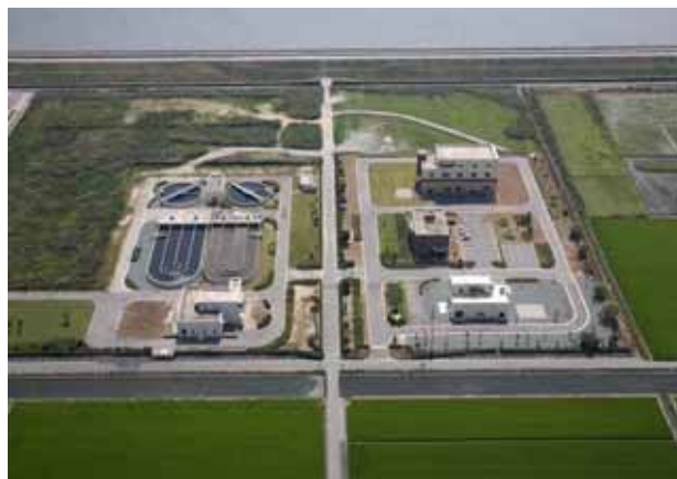
柳川浄化センター
